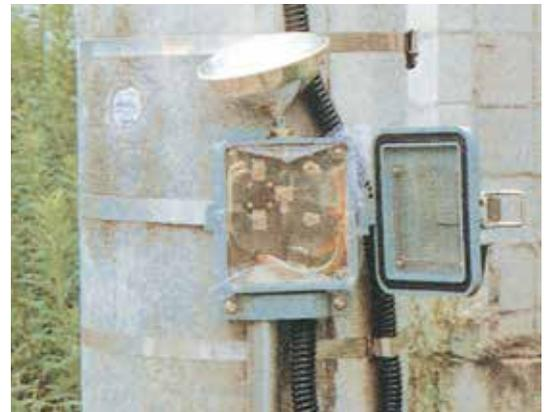
接続端子箱内部の湿気、腐食、ネジのゆるみを防止。
