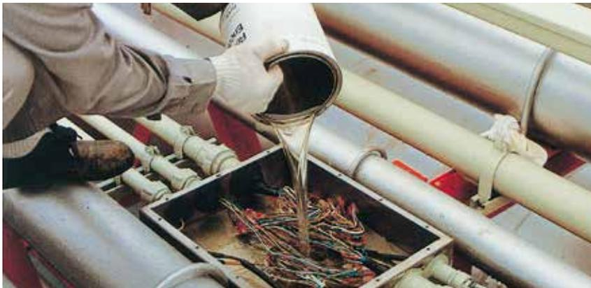
海上や海岸に設置されているパイプラインの制御ケーブル接続部の腐食、酸化を防止。
